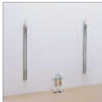
Po ukončení maliřských a obkladačských prací namontovat držáky otopných těles a po uzavření kulových ventilů odstranit spojovací kus.
