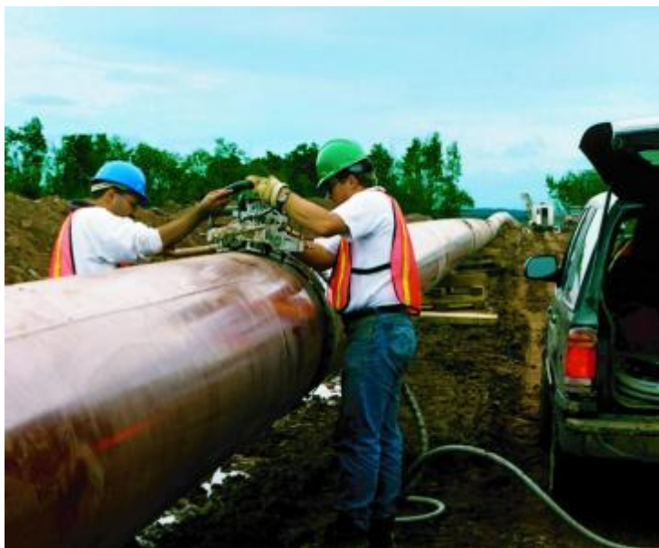
Měření na potrubí plynovodu
