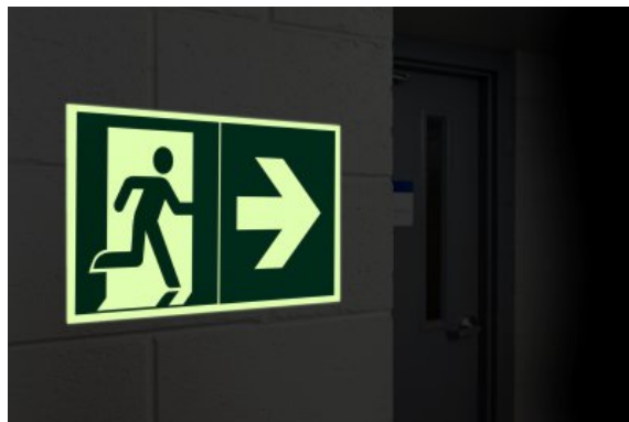
Obrázek 1: Fotoluminiscenční bezpečnostní značky nepotřebují elektřinu, preventivní prohlídky ani údržbu
