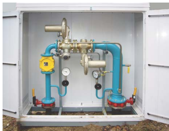
Jednořadá posilovací stanice STL NTL (sestava monitor – regulátor)
