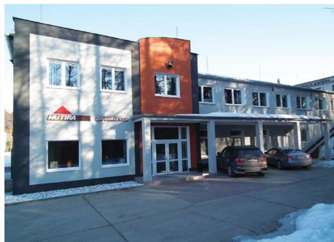
Sídlo společnosti HUTIRA Slovakia v Handlové
